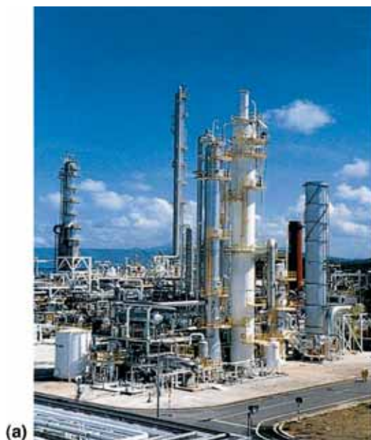
Figure RT.4. a) Piégeage postcombustion du CO 2 dans une usine de Malaisie. Un procédé chimique d'absorption sépare 0,2 MtCO 2 par an des gaz de combustion d'une centrale au gaz naturel pour produire de l'urée (avec la permission de Mitsubishi Heavy Industries). b) Piégeage précombustion du CO 2 dans une usine de gazéification du charbon située dans le Dakota du Nord (États-Unis). Un solvant physique sépare 3,3 MtCO 2 par an du courant gazeux afin de produire du gaz naturel de synthèse. Une partie du CO 2 piégé est utilisée dans un projet de récupération assistée du pétrole (RAP) au Canada.
