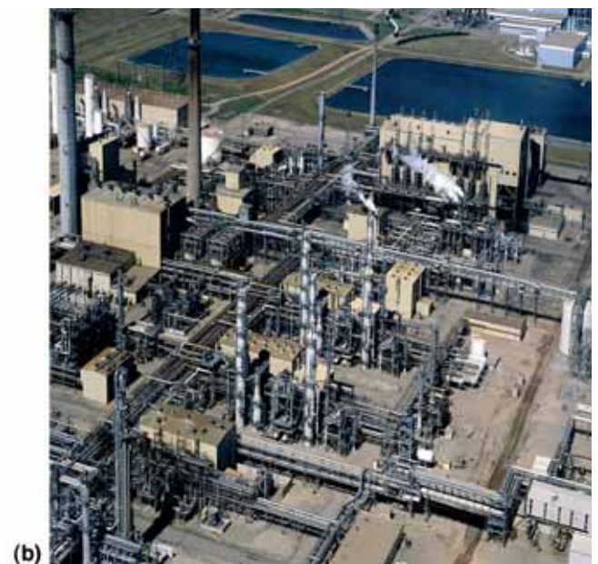
Figure RT.4. a) Piégeage postcombustion du CO 2 dans une usine de Malaisie. Un procédé chimique d'absorption sépare 0,2 MtCO 2 par an des gaz de combustion d'une centrale au gaz naturel pour produire de l'urée (avec la permission de Mitsubishi Heavy Industries). b) Piégeage précombustion du CO 2 dans une usine de gazéification du charbon située dans le Dakota du Nord (États-Unis). Un solvant physique sépare 3,3 MtCO 2 par an du courant gazeux afin de produire du gaz naturel de synthèse. Une partie du CO 2 piégé est utilisée dans un projet de récupération assistée du pétrole (RAP) au Canada.
